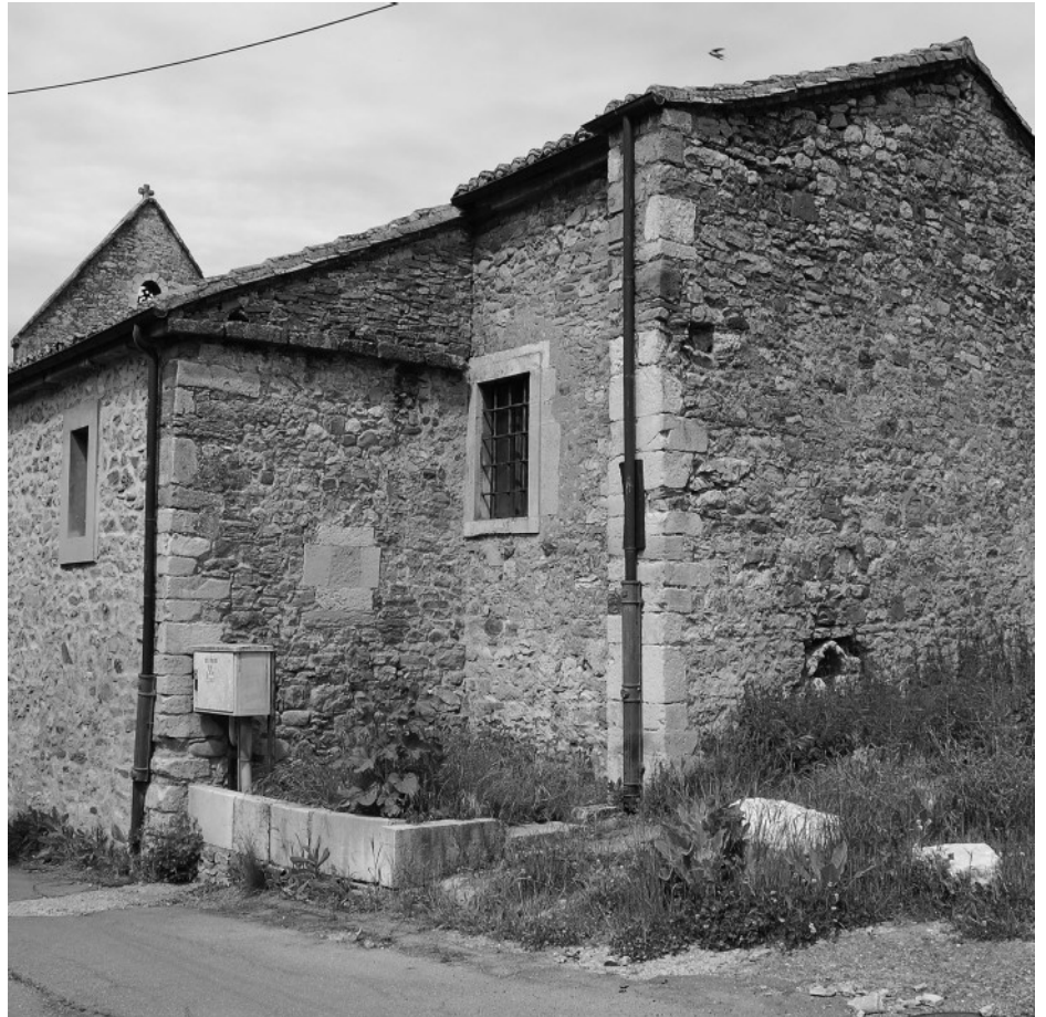
Prolongación posterior al pórtico, a modo de ábside.
