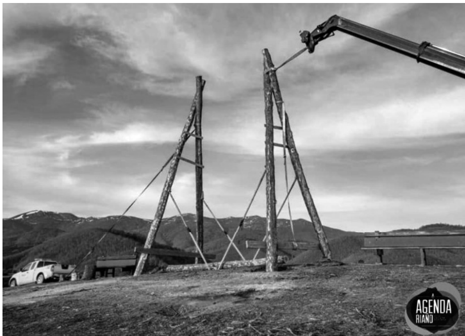
Columpio de Riaño en fase de construcción.
